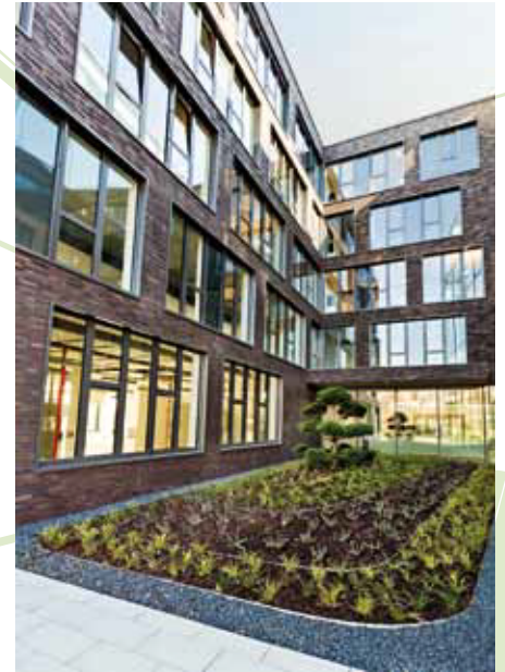
Sisäpiha jossa "Huleveden hallinta katolla"-rakente alla olevan pysäköintihallin päällä. Ratingen, Saksa.
