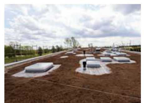
Asennettu kasvialusta "Kivikkotyypin kasvit".
